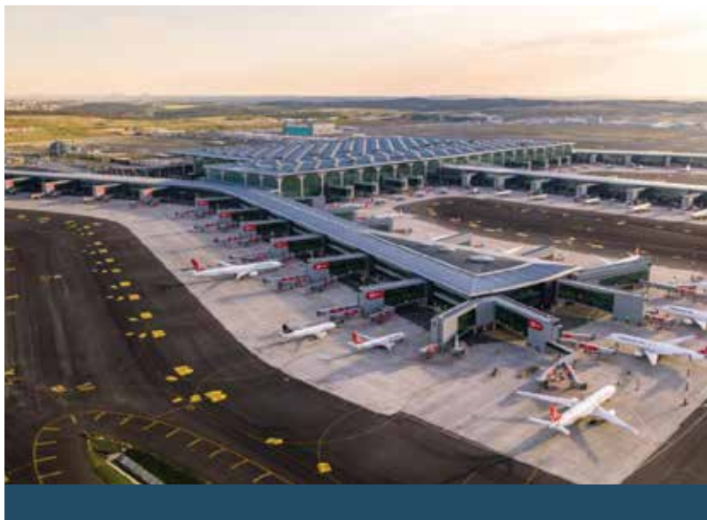
İstanbul 3. Havalimanı Güvenlik Binaları
