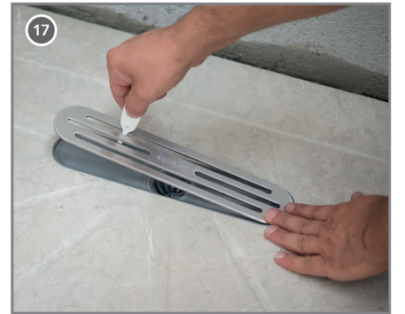
Kapak montajı yapılır. Install the cover.
