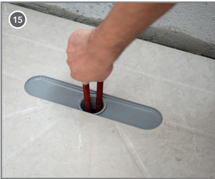
Sabitleme parçası ile sifon, sisteme sabitlenir. Fix the floor siphon to the system using the fixation piece.
