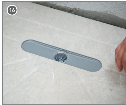
Helezon saç tutucu yuvasına yerleştirilir. Place the spiral hair trap into its housing.
